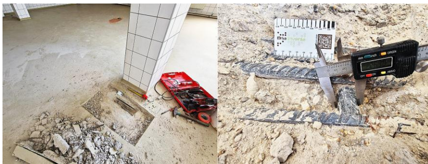
Obr. 4: Zisťovanie hornej výstuže dosky (s nutným deštruktívnym zásahom)
