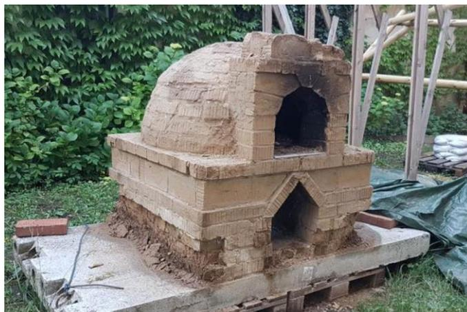
Obr. 4: Stav pece ovlivněný působením vlhkosti při absenci střechy, FA, 2021. Foto Zdeněk Vejpustek
