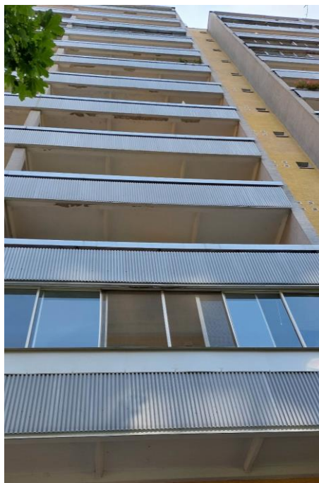
Obr. 1: Pohľad na panelový dom
