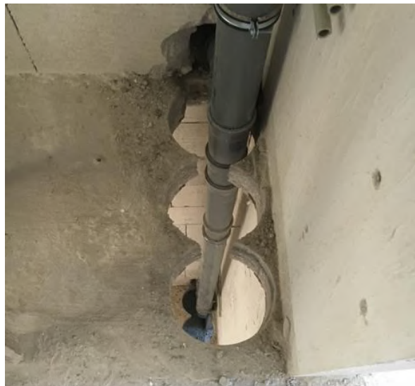
Obr.5 Oslabenie stropných dosiek novými otvormi pre kanalizáciu
