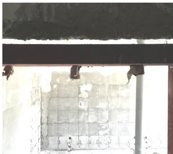
Obr.6 vytvorenie nového otvoru do stenového panelu: naľavo- nevyplnená medzera medzi betónom a oceľovým profilom, napravo vytvorenie nového otvoru v blízkosti styku dvoch kolmých panelov a poškodenie kolmého stenového panelu pri rezaní
