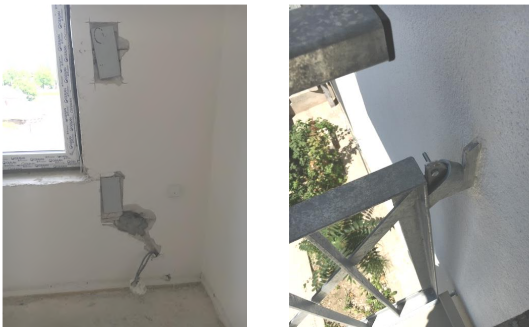
Obr. 2 Nahradenie železobetónového balkóna oceľovým: vľavo pohľad na kotevnú platňu y interiéru, vpravo pohľad na zavesenie
