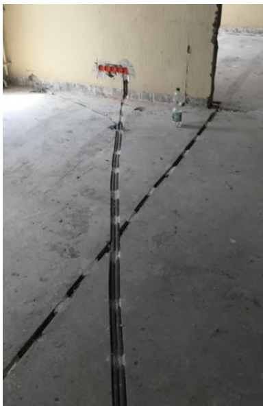
Obr.4 Naľavo - vytvorenie drážky pre elektroinštalácie pri hornom povrchu stropného panelu, v strede – drážka do stropného panelu pri spodnom povrchu, napravo – vodorovná drážka na hornom povrchu stropnej dosky pozdĺž uloženia sa steny.
