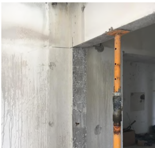
Obr.8 vytvorenie nového otvoru do stenového panelu: naľavo- nové nevystužené nadpražie stenového panelu, napravo - vytvorenie nového otvoru až po stropnú dosku
