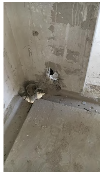
Obr.4 Naľavo - vytvorenie drážky pre elektroinštalácie pri hornom povrchu stropného panelu, v strede – drážka do stropného panelu pri spodnom povrchu, napravo – vodorovná drážka na hornom povrchu stropnej dosky pozdĺž uloženia sa steny.
