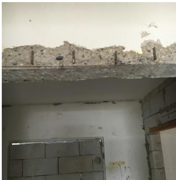
Obr.7 Naľavo: nesprávna realizácia otvoru stavebnou firmou - poškodenie betónu v rohoch, napravo: zväčšenie výšky existujúceho otvoru - poškodenie šmykovej výstuže nadpražia.
