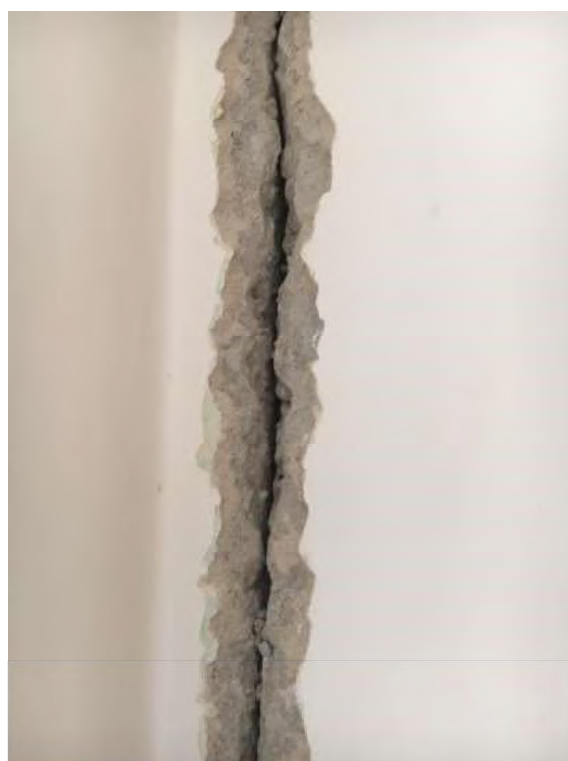
Obr. 7: Naľavo: Rozdrvený betón v stene na 11. poschodí zo strany bytu č. 47, Napravo: Odhalený styk stenových panelov na 12. poschodí
