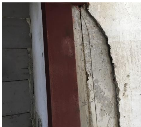
Obr.6 vytvorenie nového otvoru do stenového panelu: naľavo- nevyplnená medzera medzi betónom a oceľovým profilom, napravo vytvorenie nového otvoru v blízkosti styku dvoch kolmých panelov a poškodenie kolmého stenového panelu pri rezaní
