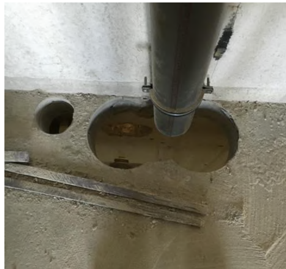
Obr.5 Oslabenie stropných dosiek novými otvormi pre kanalizáciu
