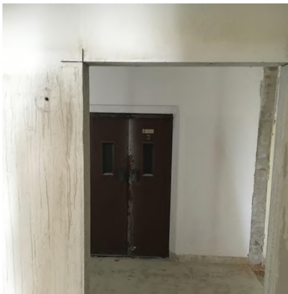
Obr.7 Naľavo: nesprávna realizácia otvoru stavebnou firmou - poškodenie betónu v rohoch, napravo: zväčšenie výšky existujúceho otvoru - poškodenie šmykovej výstuže nadpražia.
