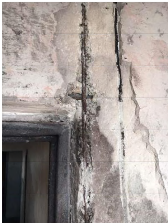
Obr. 6: Naľavo: Pohľad na trhlinu v stene na 11. poschodí zo strany bytu č. 47, napravo: Odhalená výstuž v ostení a nadpraží dverného otvoru bytu č. 48 na 11. poschodí
