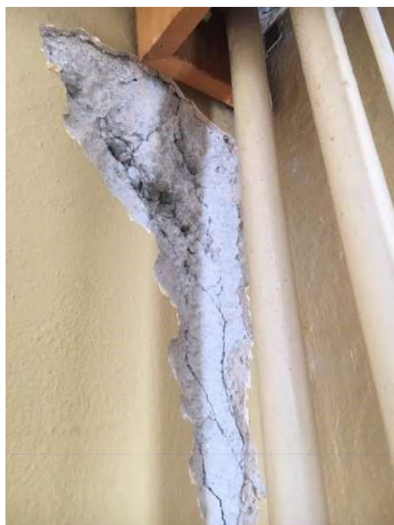
Obr. 7: Naľavo: Rozdrvený betón v stene na 11. poschodí zo strany bytu č. 47, Napravo: Odhalený styk stenových panelov na 12. poschodí
