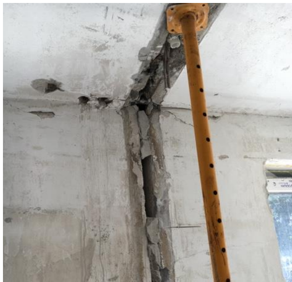
Obr.8 vytvorenie nového otvoru do stenového panelu: naľavo- nové nevystužené nadpražie stenového panelu, napravo - vytvorenie nového otvoru až po stropnú dosku
