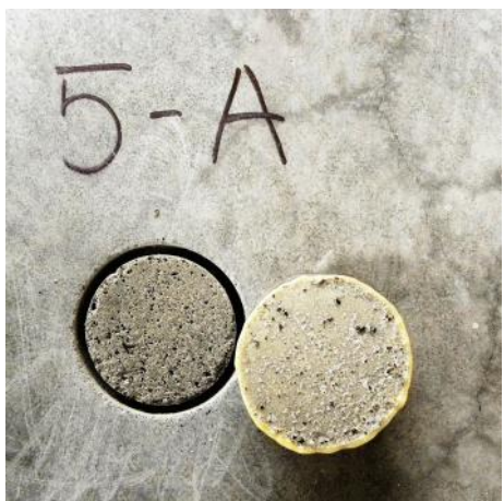
Obr. 7: Kontrola prídržnosti sanovanej vrstvy podlahy
