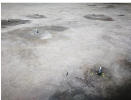
Obr. 12: Príklad injektovania podlahy
