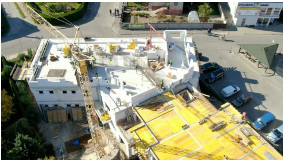
Obr. 1: Moderní stavba bytového domu SEKO Komplex v Trenčíně
