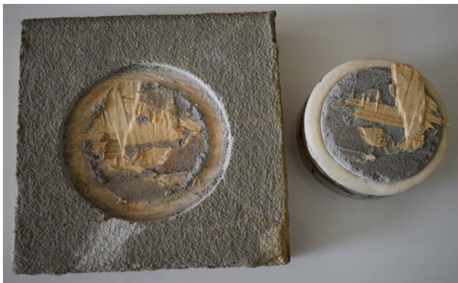
Obr. 2: Selhání přídržnosti kombinací porušení typu CSF a CF
