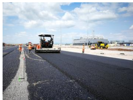
Obr. 2: Realizácia Optibase®
