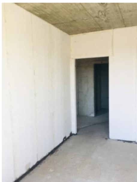
Obr. 02: Ytong příčkový panel představuje návrat k prefabrikaci a urychlení výstavby
