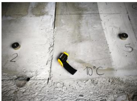
Obr. 6: Predsanačný výber mechanickej úpravy improvizovaného povrchu a kontrola aplikačných podmienok (teploty)
