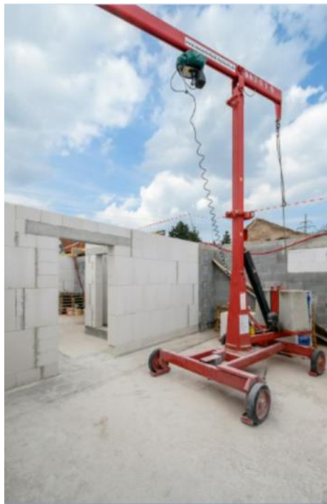
Obr. 3: Minijeřáb určený pro zdění vápenopískových a porobetonových tvárnic s nosností 400kg
