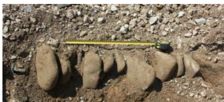
Obr. 5: Odkrytá pôvodná vrstva vozovky na moste v Krásne nad Kysucou
