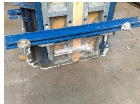
Obr. 11: Utesnenie styku debnenia stĺpa a stropnej konštrukcie technickou penou
