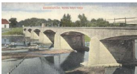
Obr. 7: Bývalý železobetónový most v Nových Zámkoch z roku 1893
