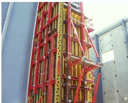
Obr. 8: Stúženie stenového debnenia proti hydrostatickému tlaku
