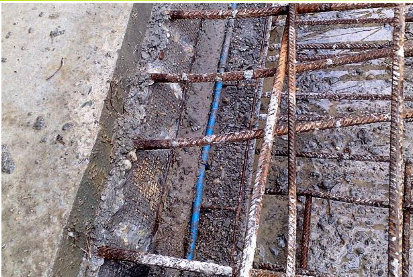
Obr. 13: Pohľad na pracovnú škáru s injektážnou hadičkou
