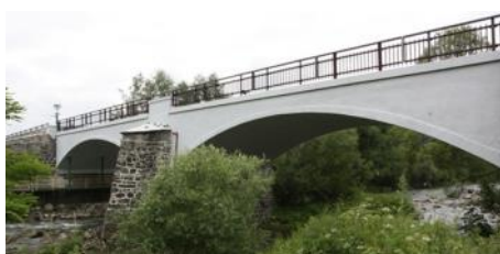
Obr. 2: Most v Krásne nad Kysucou po rekonštrukcii v roku 2014
