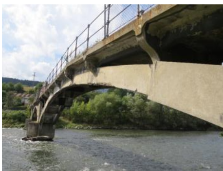
Obr. 13: Pohľad jeden z hlavných nosných oblúkov a priečniky lávky pri Ružomberku z pravého brehu Váhu
