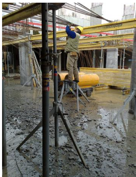
Obr. 9: Odebrávanie stropu (pokračovanie stropnej dosky)
