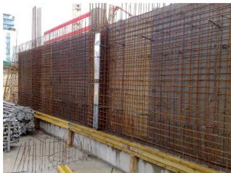
Obr. 10: Debnenie steny s prípravou napojenia kolmej steny (tzv. vylamovacou výstužou)
