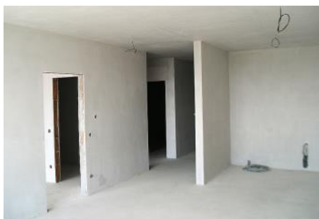
Obr. 4: Vnútorne omietky bytového domu
