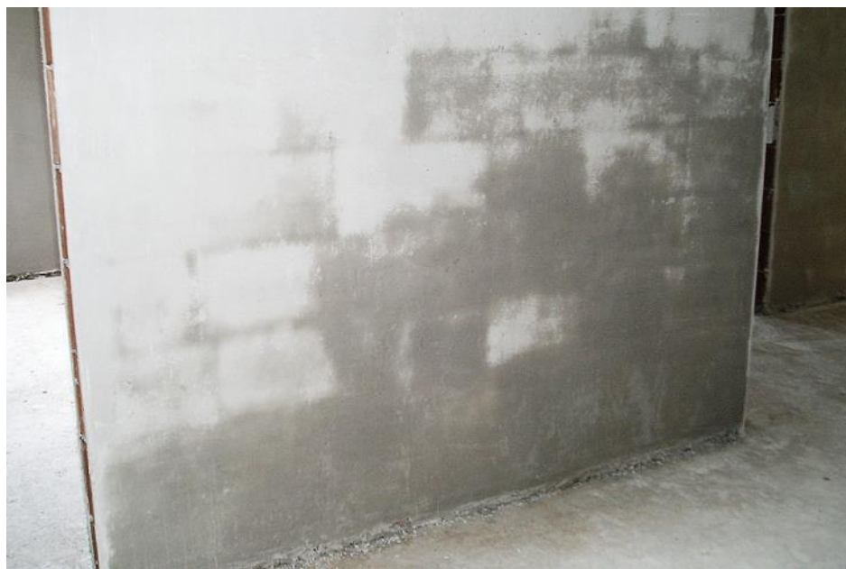
Obr. 7: Rýchle vyschnutie omietky, odsatie vody do podkladu
