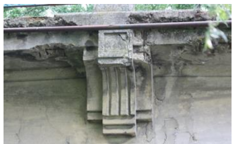
Obr. 11: Železobetónový ornament na hornej stavbe v mieste uloženia na piliere
