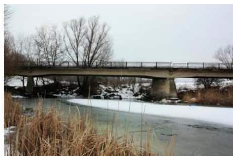
Obr. 10: Zachované predpolia mosta pri Hlohovci (fotografia z roku 2012)
