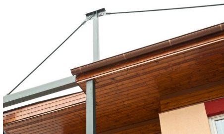
Obr. 2: Náter dreveného podlahu a ocelevej konštrukcie strechy, Prievdiza
